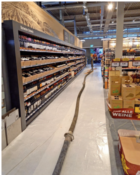
Baustelle Coop Rickenbach Pumpleitung 45 Meter Länge
