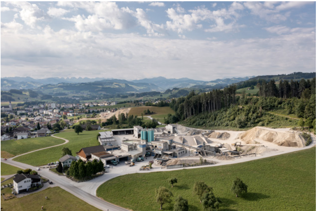
Hinten: Kiesabbaugebiet Chrobüel Mitte: Kies- und Betonwerk
